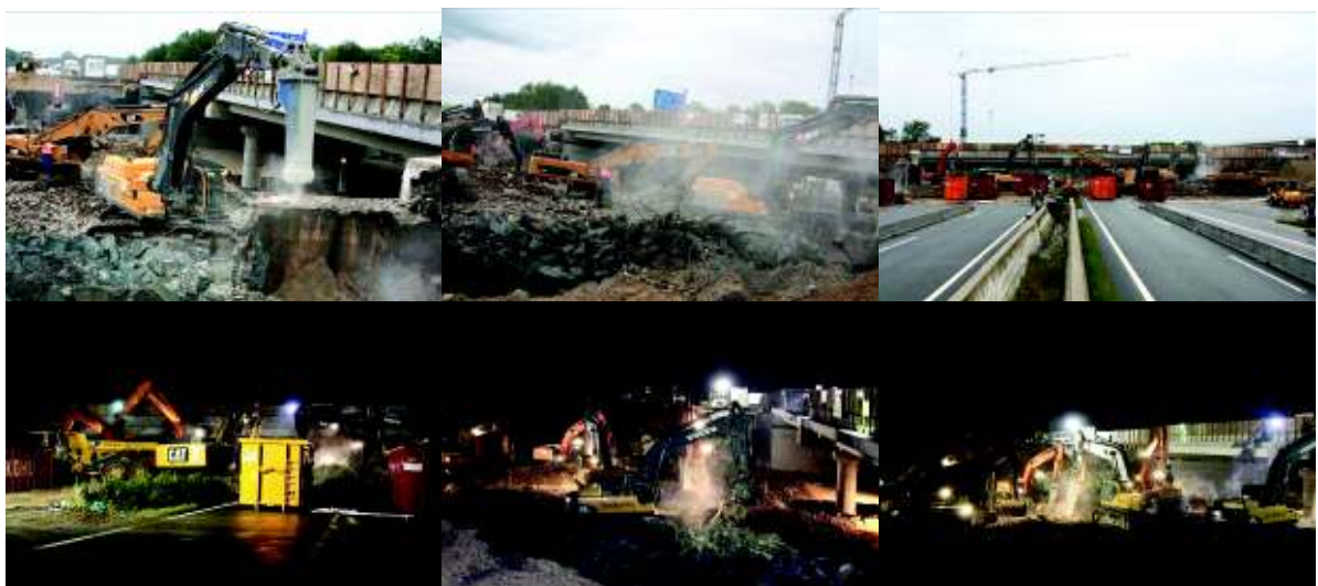
Brückenabriss A 1, August 2011
